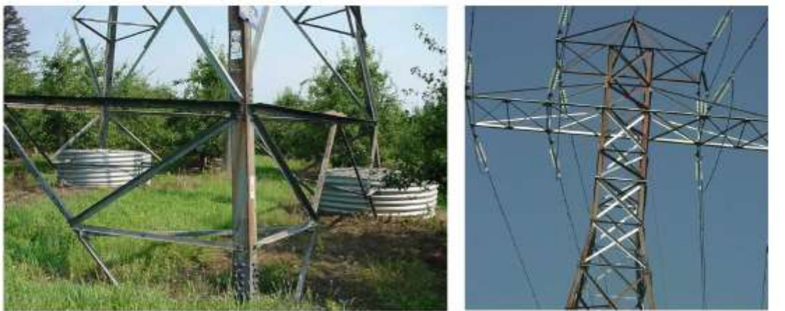
شکل ۱: مقاوم سازی دکل به علت فرسودگی و تغییر حریم زمینی (اونتاریو کانادا) [۳]
