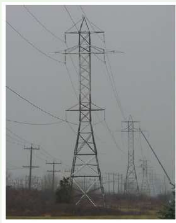
شکل ۲: مقاوم سازی دکل به علت تغییر حریم عمودی دکل (بازوهای میانی جدید و بدنه میانی اضافه شده) [۳]
